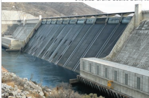
01.06.b2 Grand Coulee Dam, WA
